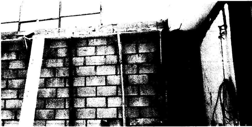
ENCOFRADO DE VIGA SOLERA
