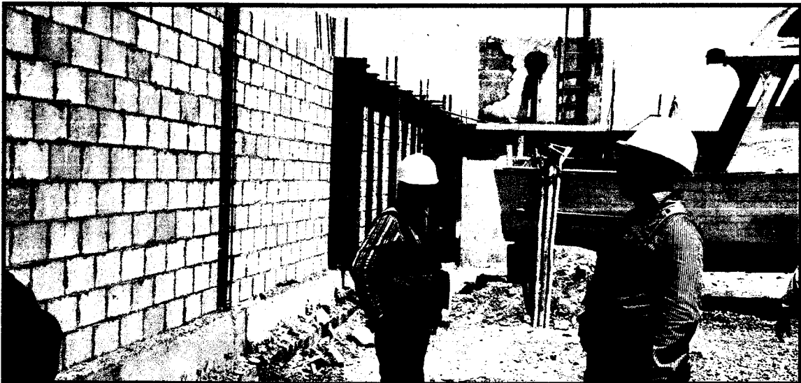
ASENTADO DE BLOQUES DE CONCRETO
